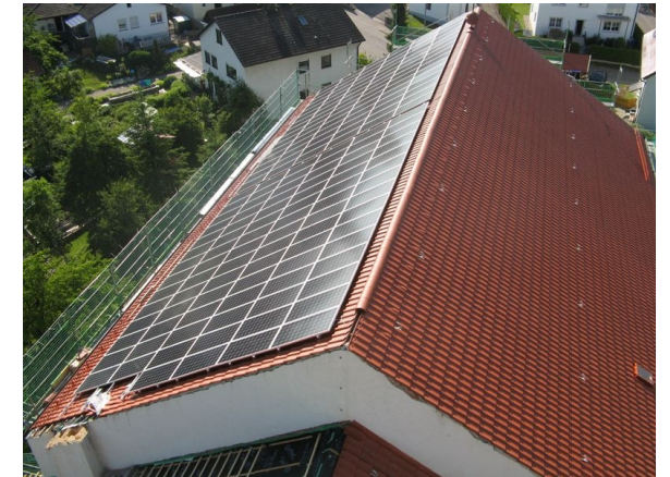
Fotovoltaikanlage auf der Heilig Kreuz Kirche in Straßberg/Bobingen
